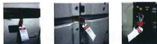
รูปแสดงการตัดแยกไฟฟ้าในอาคาร (Substation)
